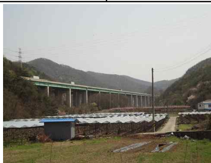
교 량 명 남천교 구조형식 STEEL BOX GIRDER
