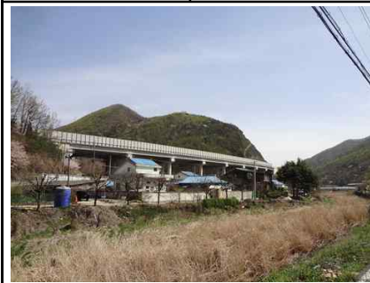
교 량 명 원리교 구조형식 PSC BEAM
