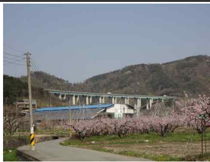
교 량 명 청도2교 구조형식 STEEL BOX GIRDER
